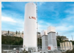
浅羽工場 蒸気ボイラー CO 2 削減比率 ▲40%(従来比) 効果が期待される
